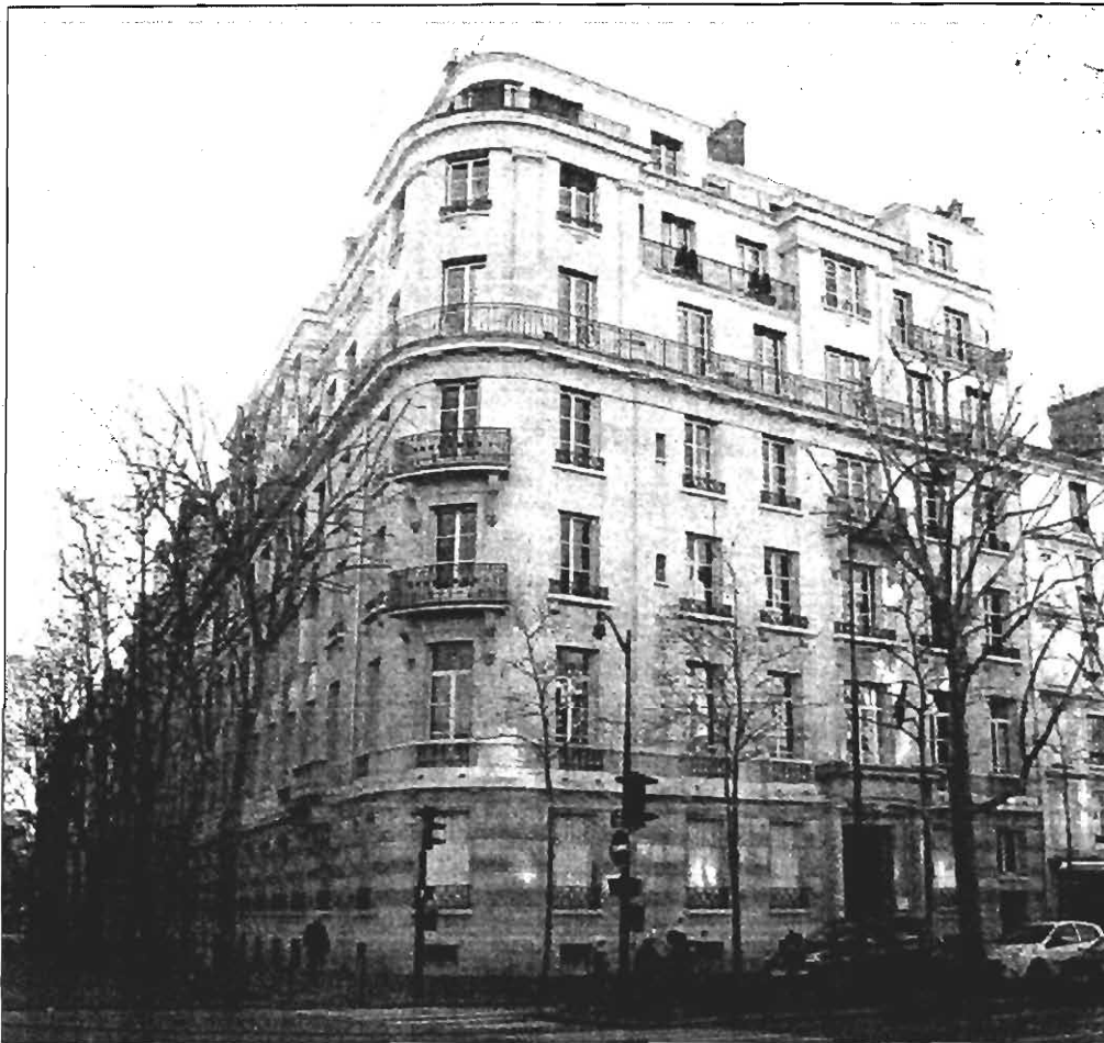
L'immeuble de la CANSSM, état actuel (cliché F. de Béru)
