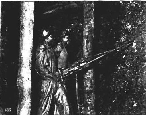
Mineurs actionnant leurs marteaux-piqueurs pneumatiques
